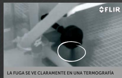
LA FUGA SE VE CLARAMENTE EN UNA TERMOGRAFÍA
